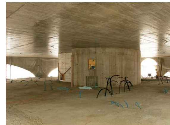
La struttura portante allo stato grezzo con gli elementi di rinforzo costituiti dal telaio dei piani, dalla parete del vano scale e dal nucleo dell'ascensore.
