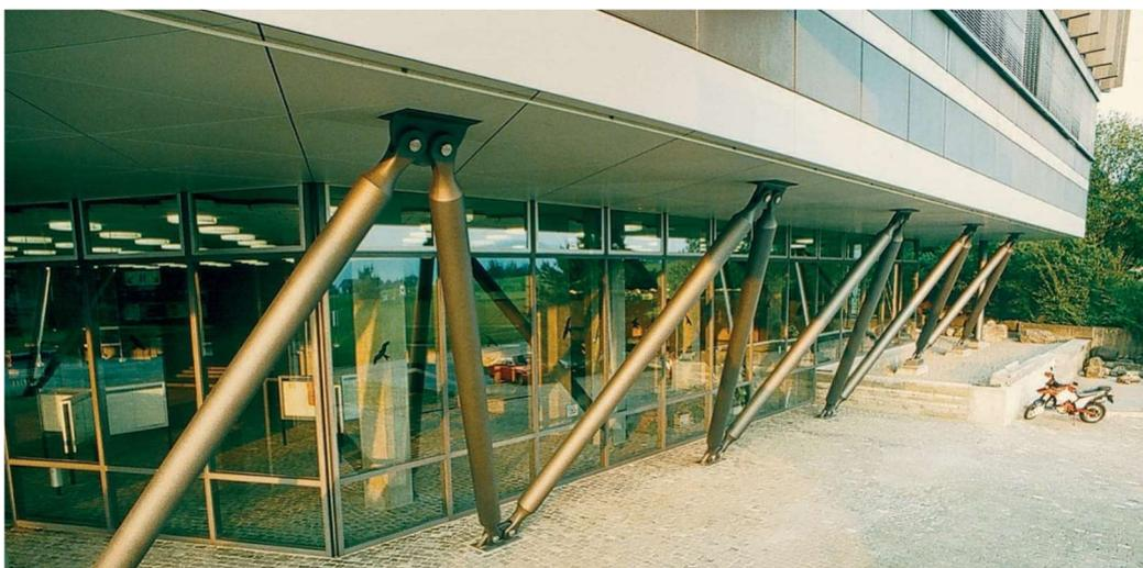
*Die neuen Fachwerkstützen aus Stahlrohren fügen sich ästhetisch befriedigend in das bestehende Gebäude ein.*
