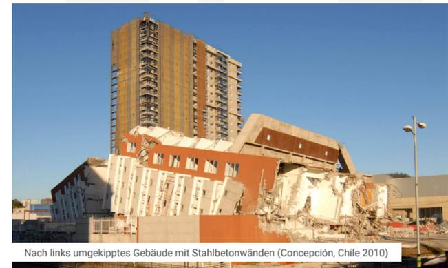
Nach links umgekipptes Gebäude mit Stahlbetonwänden (Concepción, Chile 2010)
