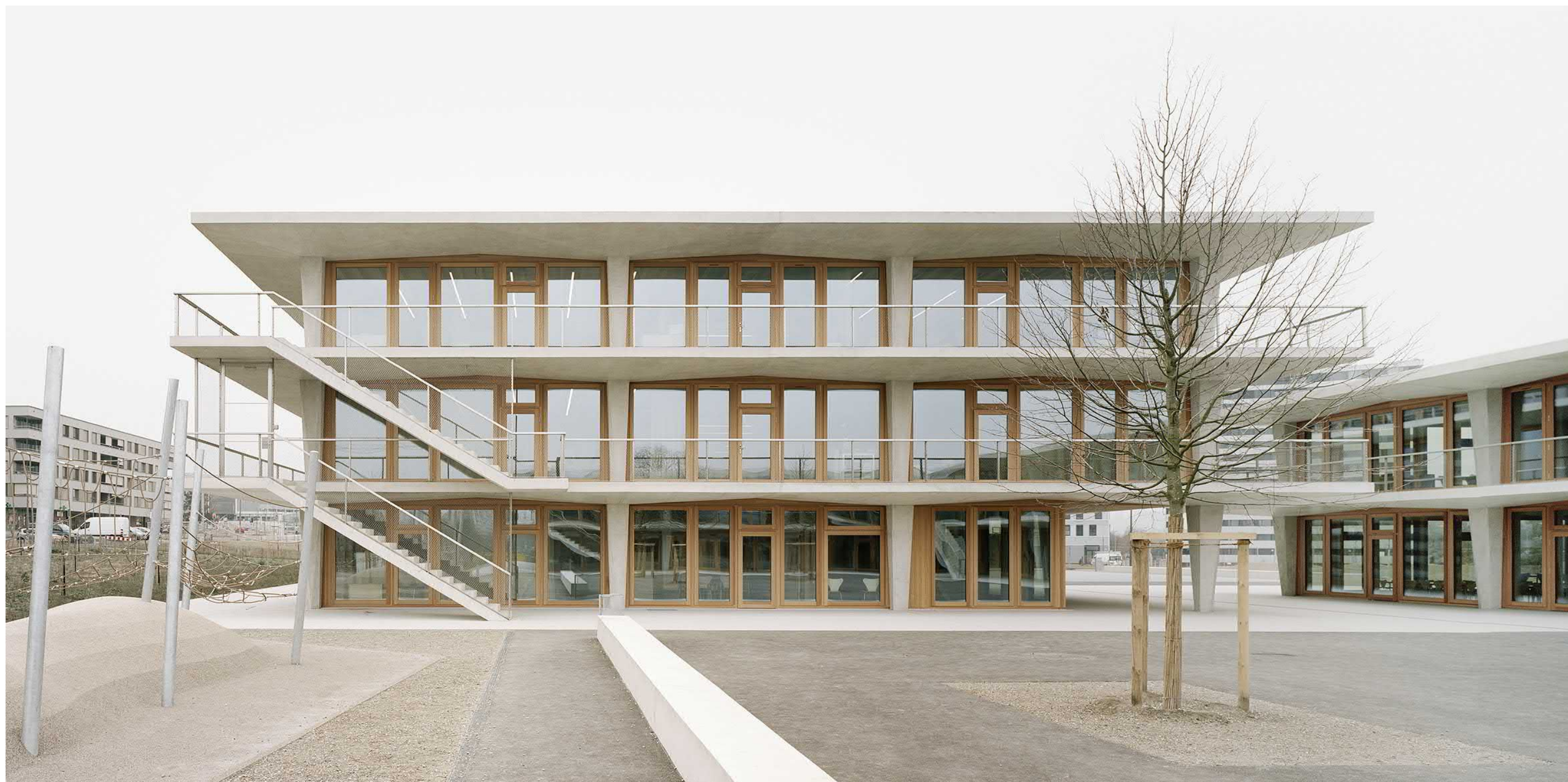
Équipements publics de l'Eco-quartier Les Vergers, Meyrin Proposition pour le Prix d'architecture et d'ingénierie parasismique 2021
