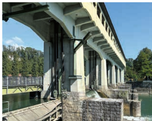
Das Wehr Winznau im Bau (oben) und heute.
