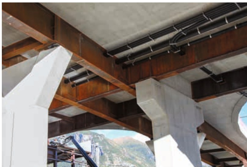
Zwei neue Rampen führen auf die ertüchtigte «Grossi Brigga Gesch» bei Raron VS. Neu ist die Brücke schwimmend gelagert .
