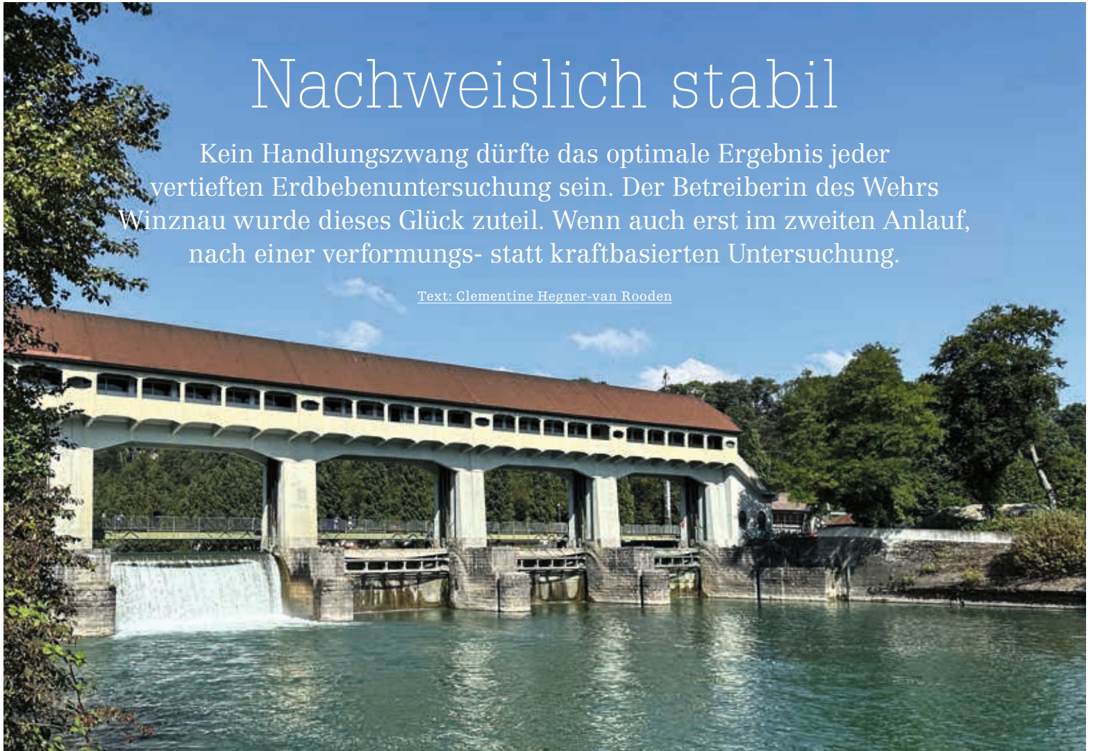
Das Stauwehr Winznau: Der Erhalt des Wehrgangs mitsamt der Schützen bedurfte weiterführenden Erdbeben-Analysen.
