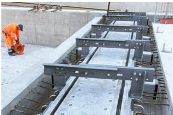
Eine Lamellenfuge mit Fuse-Element beim Einbau. Bei starker horizontaler Belastung im Fall eines Erdbebens gibt das Abdeckblech eine grosse Fuge frei.
