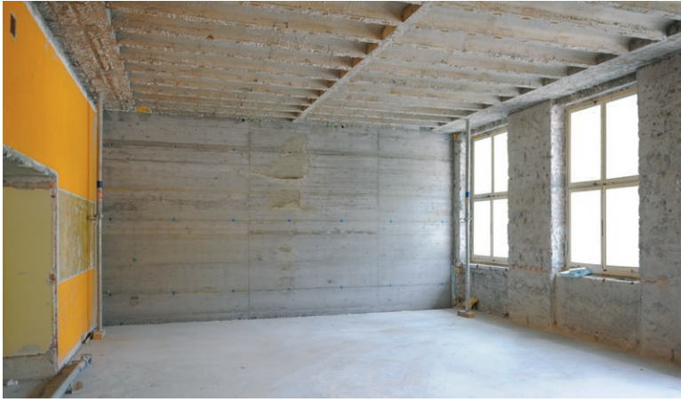
Oben: Schulzimmer mit Rippendecke und neuer Erdbebenwand / salle de classe avec un plafond nervuré et une nouvelle paroi parasismique Rechts: Bewehrungsplan neue Erdbebenwände inkl. Mikropfähle / plan de l'armature des nouvelles parois parasismiques incluant les micropieux Unten: Grundriss EG mit neuen Erdbebenwänden in grün / vue en plan du rez-de chaussée avec les nouvelles parois parasismiques en vert Foto / Bilder: Karin Vonow, Schwander & Sutter, Bänziger Partner
