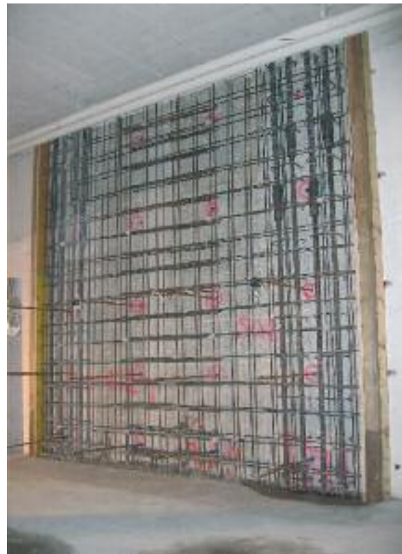
Neue, über die ganze Gebäudehöhe laufende Stahlbetonwände zur Abtragung der Erdbebenkräfte: Anordnung im Grundriss (links, grün) und fertig montierte Bewehrung (oben) / Nouveaux refends en béton armé reprenant les forces sismiques, qui s'étendent sur toute la hauteur du bâtiment: disposition en plan (à gauche, en vert) et armature achevée (en haut)
