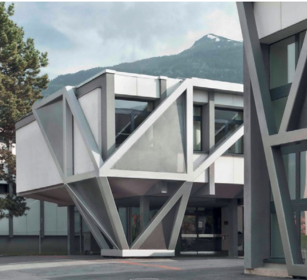
Erdbebenverstärktes Schulhaus in Monthey VS, ausgezeichnet mit dem Architektur- und Ingenieurpreis erdbebensicheres Bauen 2012 der Stiftung für Baudynamik und Erdbebeningenieurwesen. Projektverfasser: Kurmann & Crétton SA, Monthey, (Foto: Philomène Hoël, Eiko Frenzel).
