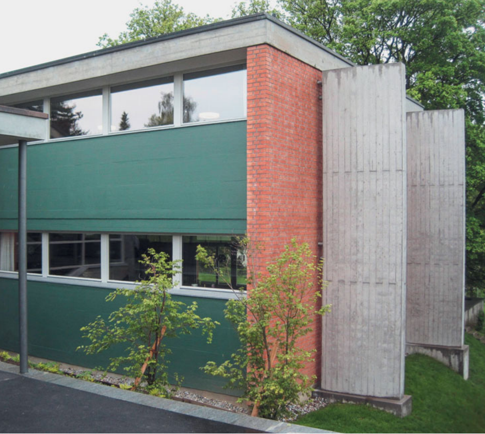
Erdbebenverstärkte Schulanlage Feldli in St.Gallen: Zwei neue Stahlbetonwände ausserhalb des bestehenden Gebäudes wirken stabilisierend. Projektverfasser: Conzett Bronzini Partner AG, Chur
