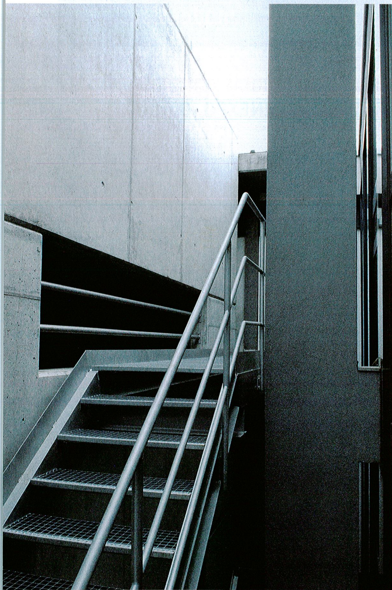
Vue de l'intérieur d'un des nouveaux noyaux de contreventement en béton.
