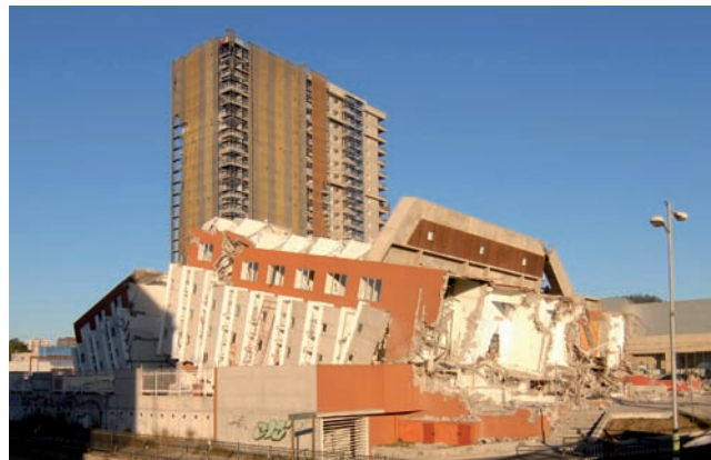
Nach links umgekipptes Gebäude mit Stahlbetonwänden (Concepción, Chile 2010)
