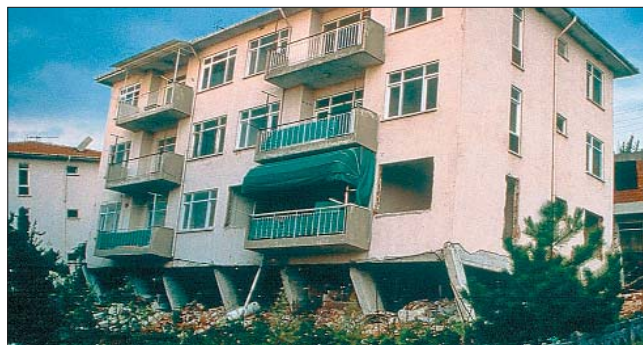
Bâtiment avec un rez-de-chaussée flexible (Izmit, Turquie, 1999)
