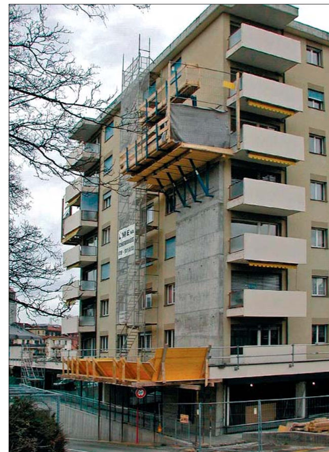
Bâtiment résidentiel en maçonnerie situé à Fribourg, avec 4 parois élancées en béton armé appliquées contre les façades extérieures
