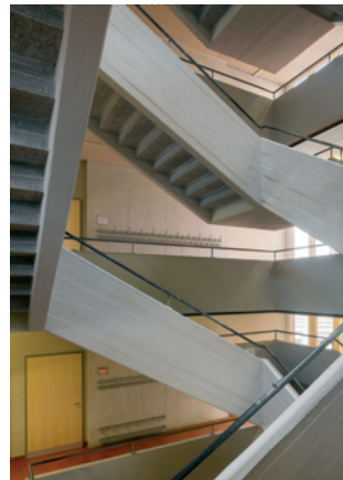
De nouvelles parois parasismiques ont été habilement intégrées dans un bâtiment conforté (complexe scolaire de Riedenhalden, Zurich, 2007)
