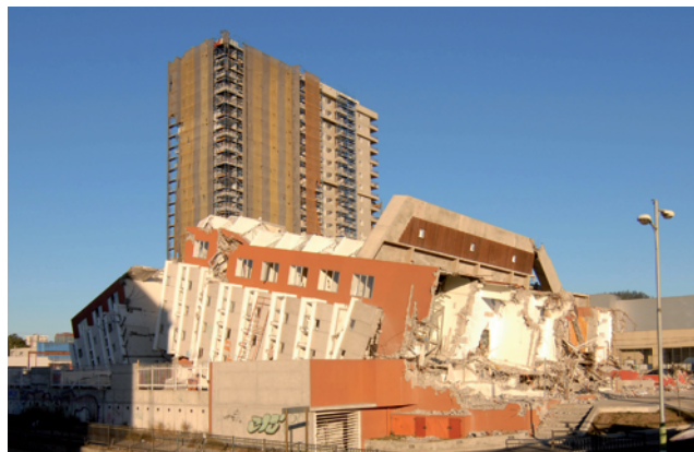
Bâtiment avec des parois en béton armé incliné vers la gauche (Concepción, Chili, 2010)
