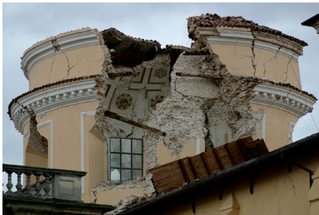
Sans confortement parasismique, des biens culturels précieux peuvent subir des dégâts difficilement réparables (église à L'Aquila, Italie, 2009)
